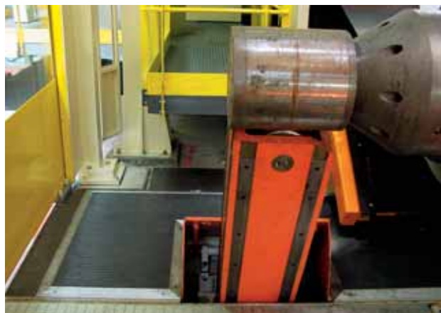
Fig. 4 - Protezione omogenea di vaste aree
